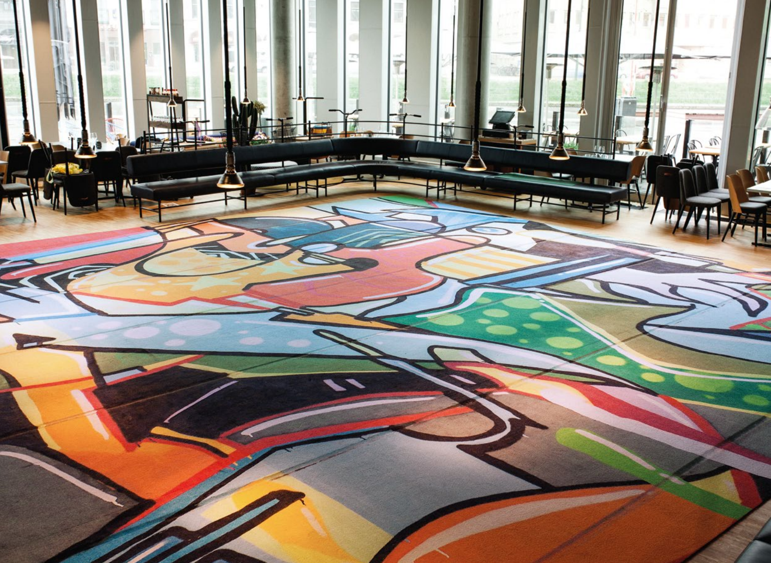
Installation av restaurangmatta med grafittimotiv, Clarion Malmö Live Hotell & Kongress, Malmö.
