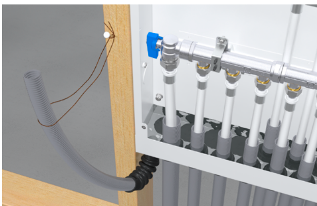
Täthetskontroll av skåpsbotten
