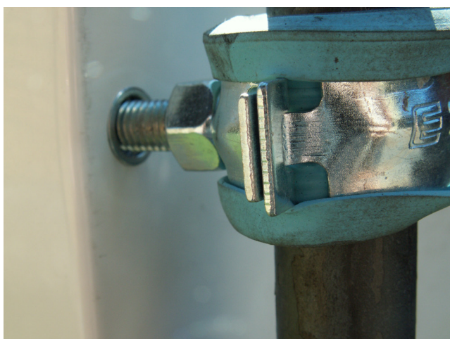
Närbild på infästning mot skåp.
