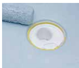
Rolla hela golvet med LIP VS 30 Membrantätskikt fram till klämringen. Materialåtgång ca 750 g/m 2 . För vidare behandling, se sid. 9, punkt 5 - 6.
