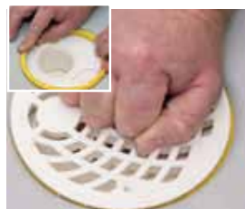
Sätt i klämringen med hjälp av golvbrunnssilen.
