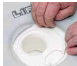
Se till att trycka fast tätarket och arbeta bort luftblåsor. Forma tätarket efter golvbrunnen.
