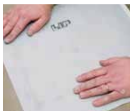
Klistra fast halva LIP Tätark på den torra LIP VS 20 Ångspärren (för att lättare ta bort Puruskniven).
