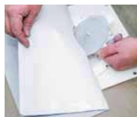
Skär upp hålet, vik upp den lösa halvan. Ta bort hållaren och montera fast resterande tätark.
