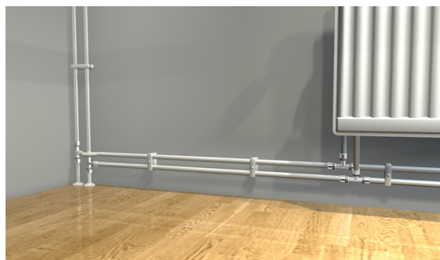
Exempel klamring med synligt montage.
