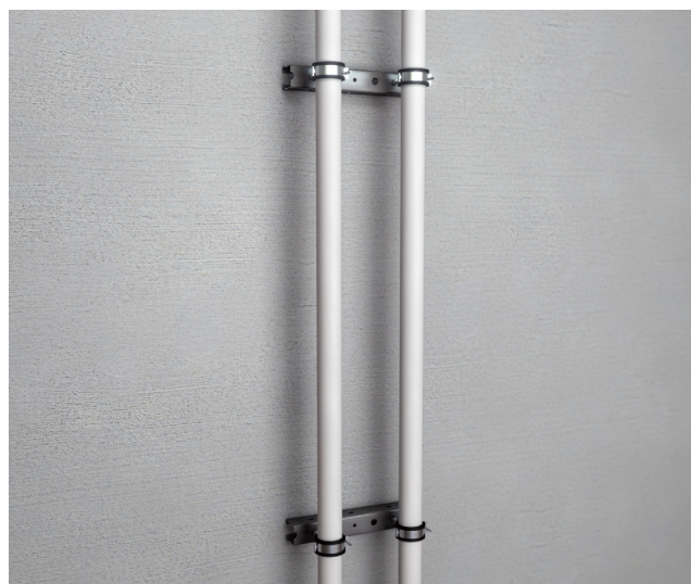
Exempel klamring vid vertikalt montage.
