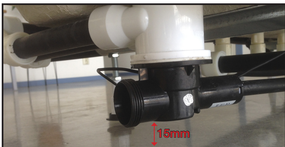
Bild 2.1 - Avstånd bottenventil och golv
