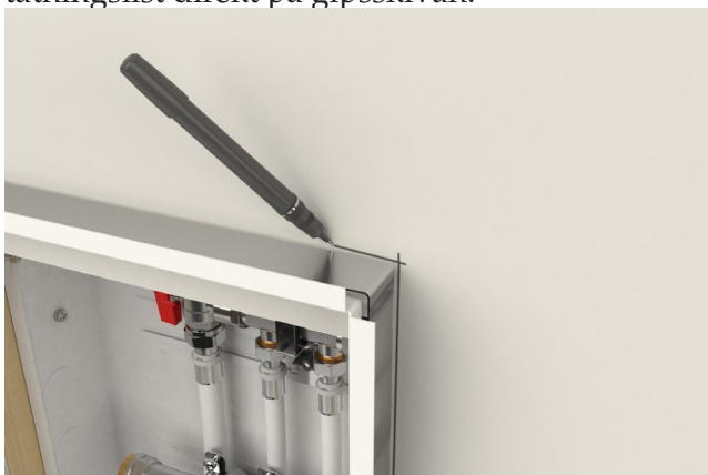
Markera ramens utsida på gipsskivan
