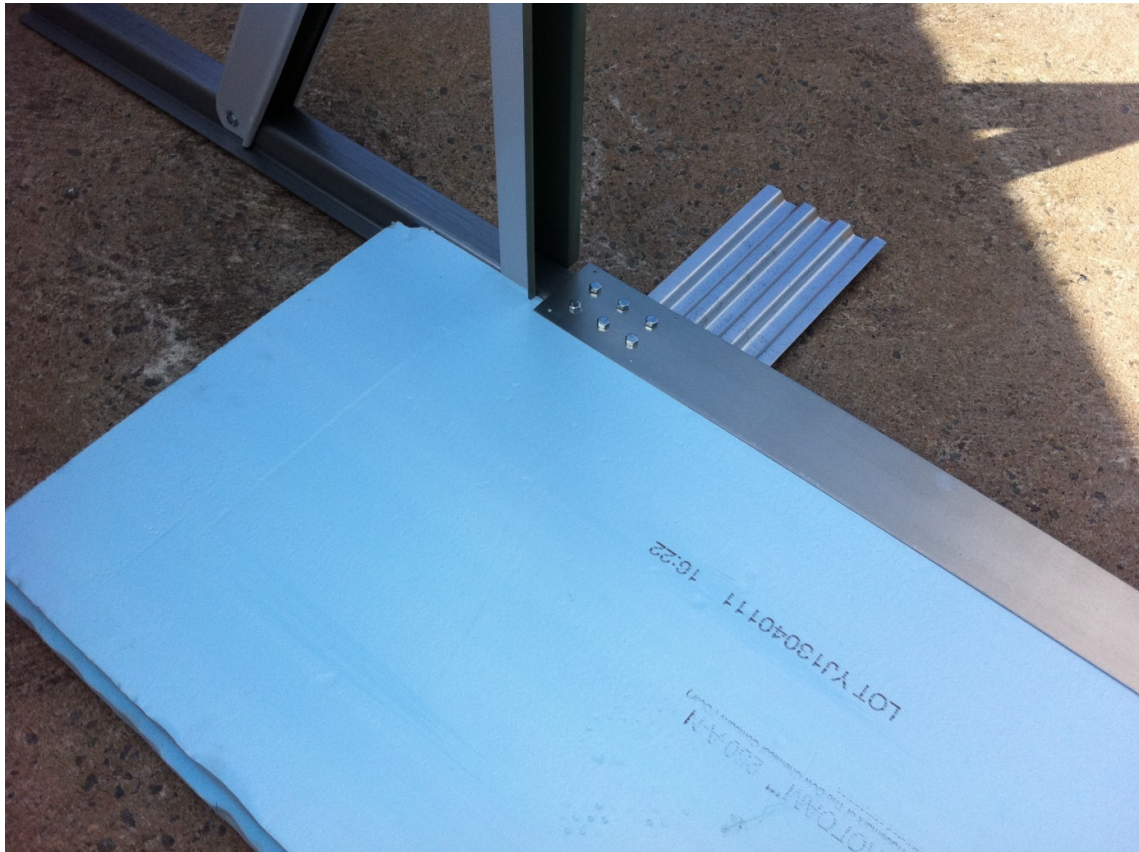
Bild 4: Spännbandets bultförband spacklas ut till en jämnare form med ett 2 komponent spackel innan bottenmattan (nålfilt eller liknande) läggs i poolen för att undvika mekanisk åverkan på bottenmattan från bultskallarna.
